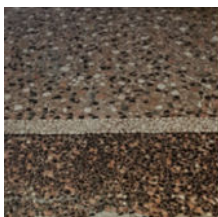
Piano secondo | recupero battuto veneziano/ ripristino
